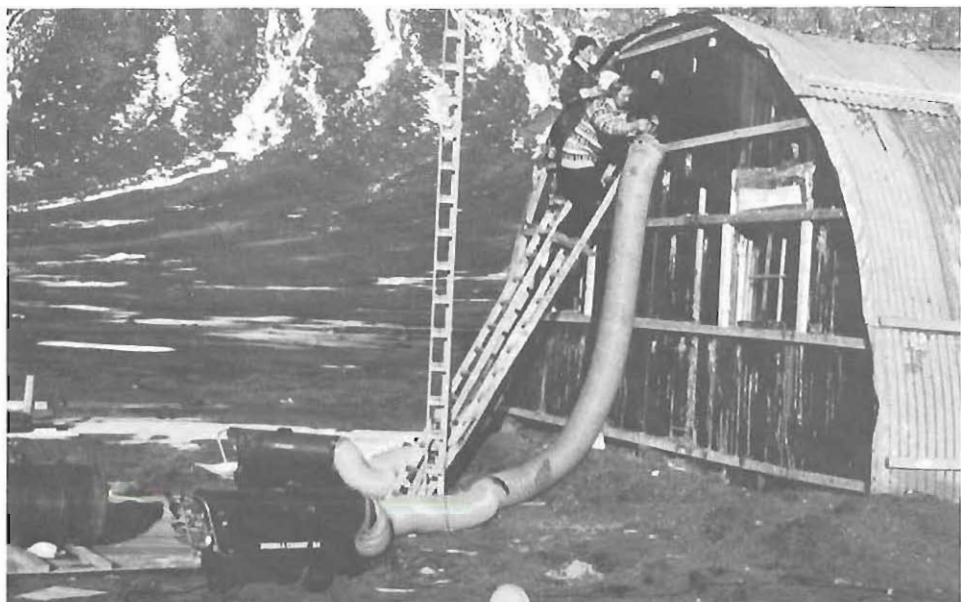
Isolatiwerkzaamheden aan de voorkant van de hut.
